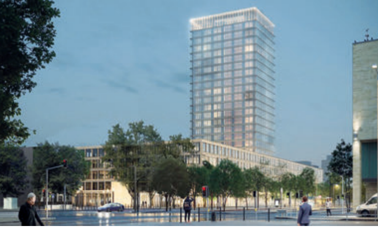
Ahşap hibrit bina olarak yüksek bina: Kreisverwaltung Landratsamt Karlsruhe, Telif hakki: wittfoht studio architekten Ieesome
