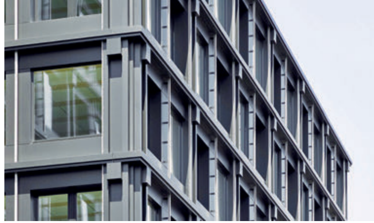
Risch'teki ilk İsviçre ahşap yüksek binası: BauBuche'den yapılmış sütunlar ve kirişler ile ahşap çerçeve konstrüksiyonu. Mimar Burkard Meyer Architekt BSA, ahşap yapı: Erne AG Holzbau, inşaat mühendisi: MWV Bauingenieure AG Telif hakki: Pollmeier Massivholz GmbH
